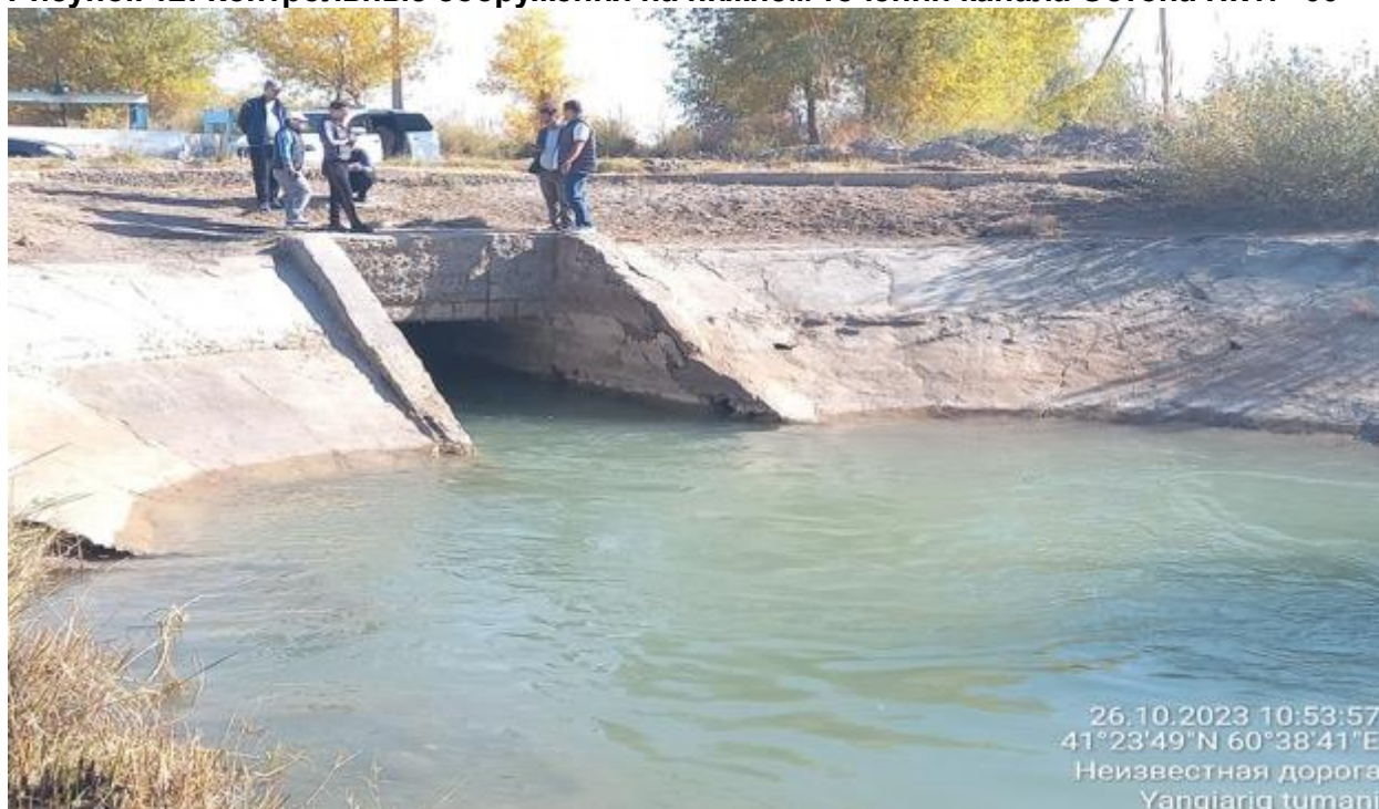
Рисунок 12: Контрольные сооружения на нижнем течении канала Остона ПК17+00
