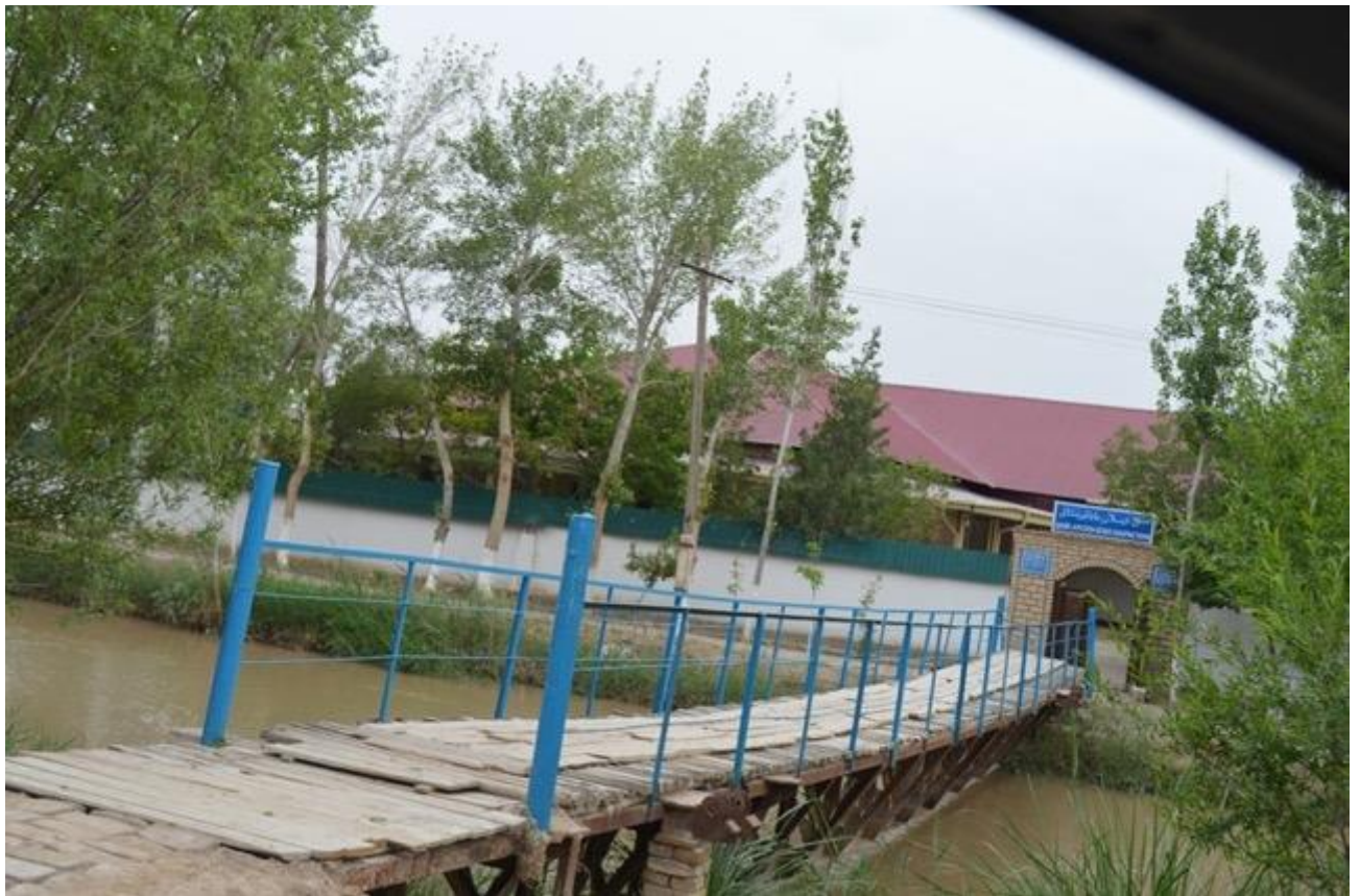
Картинка 6: Пешеходный мост на РК 262+00 (фото датировано 04.03.20230)
