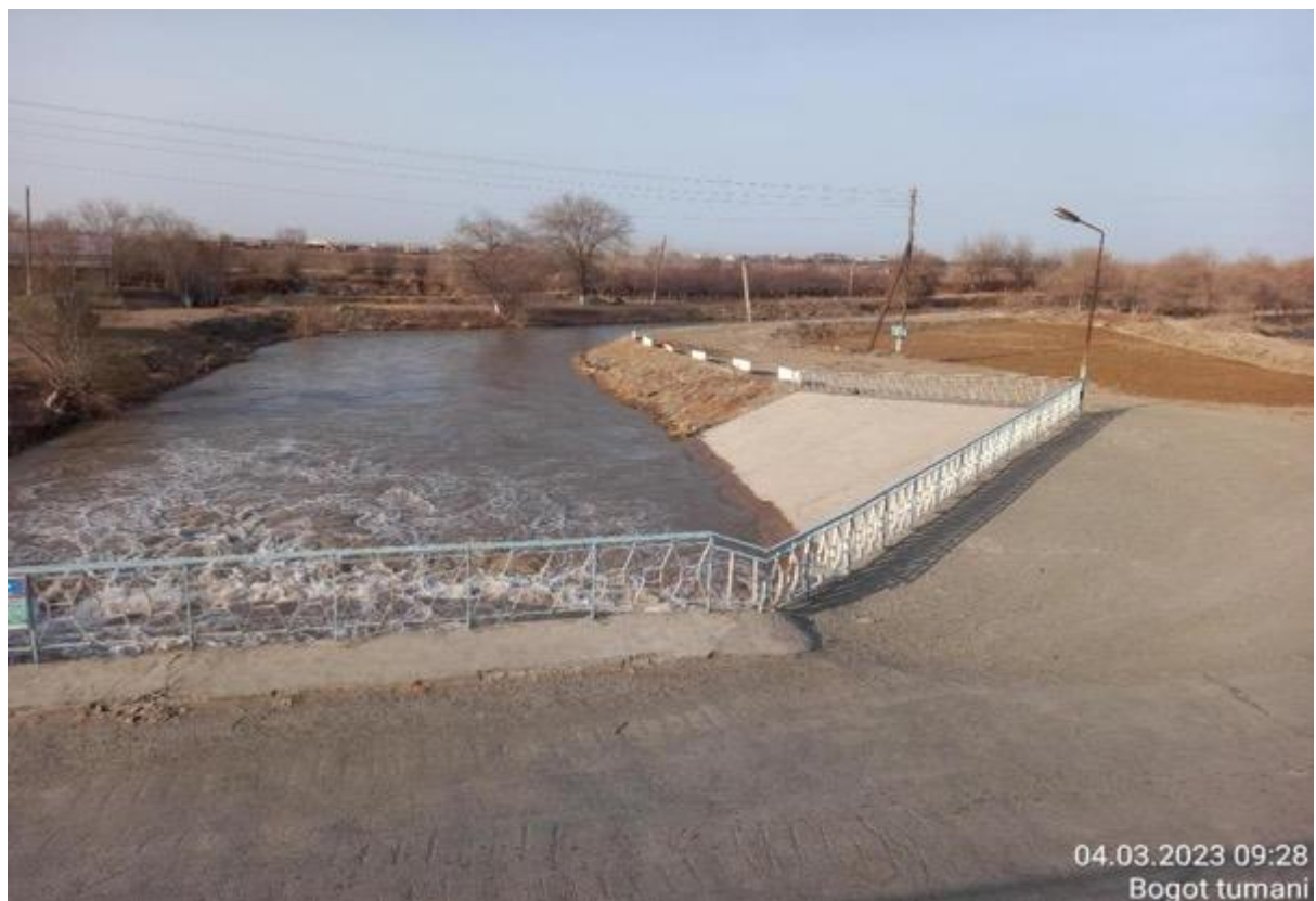
Картинка 5: Канал R8 - вид с головного сооружения (РК 0+00)
