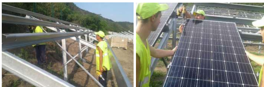
3.5-расм. Қуёш фотоэлектрик станцияларини монтаж қилиниши
