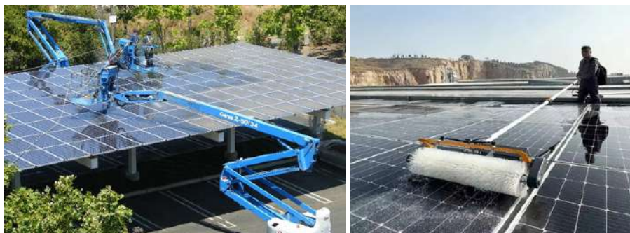
3.7-расм. Қуёш панелларини тозалаш жараёни
