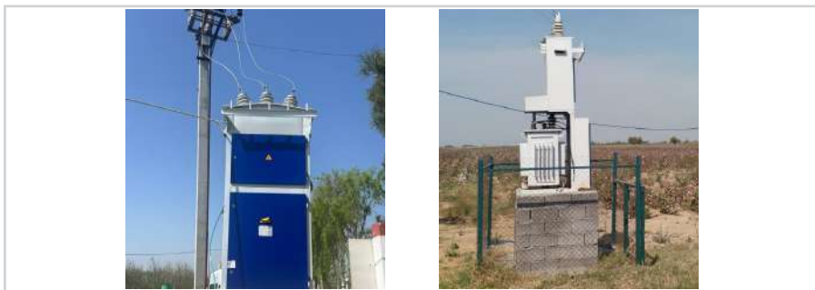
16-расм. Юқори кучланишни пасайтирувчи кичик трансформатор
