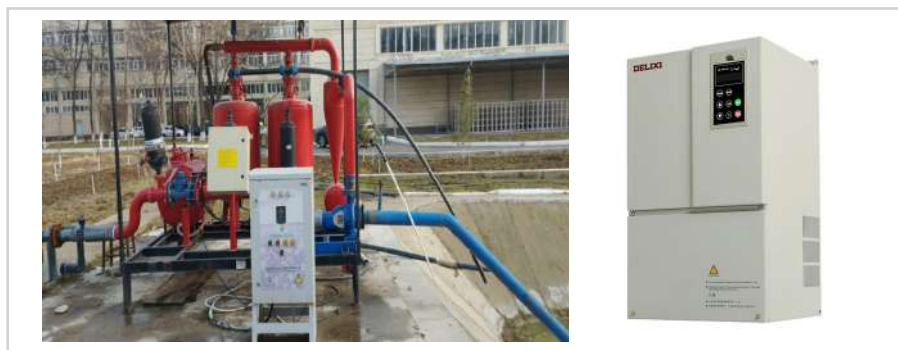
15-расм. Электрдвигателнинг айланиш частотасини ўзгартиргич қурилмаси (инвертор)
