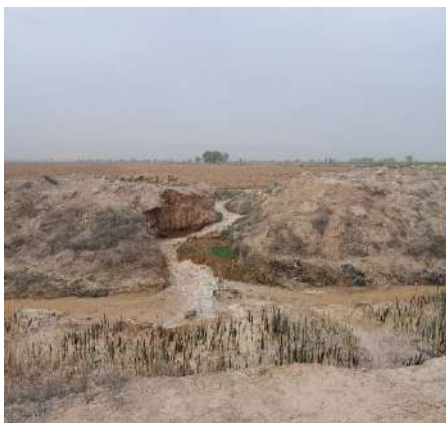
1.7-расм. Коллектор-дренаж тармоғи ўзанига зарар етказиш
