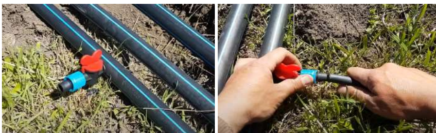
49-расм. Тарқатувчи қувурга штуцерларни, штуцерларга суғориш қувурини улаш
