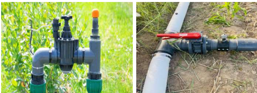
19-расм. Суғориш қувурларидаги клапанлар
