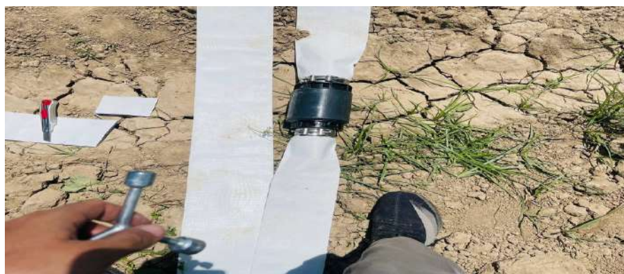
47-расм. Тарқатувчи қувурларни улаш
