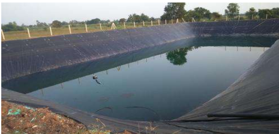
39-расм. Геомембрана қопламали ҳовуз-тиндиргич
