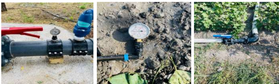
18-расм. Суғориш тизими қувурларида монометрларни ўрнатиш.
