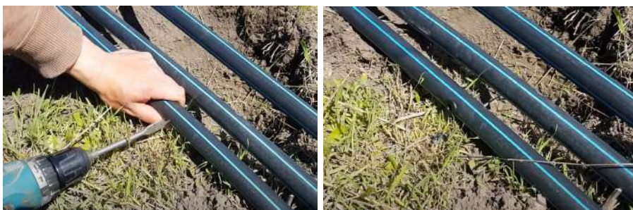
48-расм. Тарқатувчи қувурларни белгиланган жойларини тешиш ҳамда махсус резина ниппел жойлаштириш
