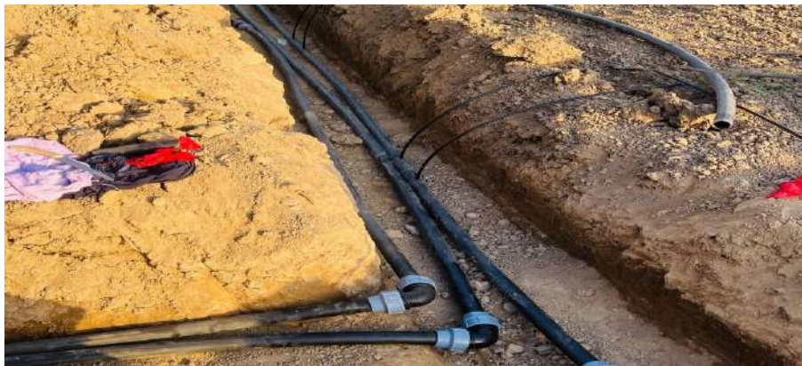
46-расм. Тарқатувчи қувурларни ҳандакка жойлаштириш
