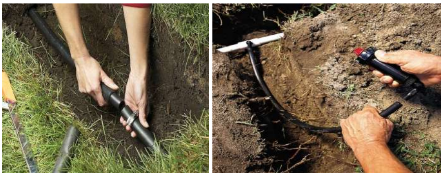
53-расм. Қувурларни фитинг ёрдамида бирлаштириш (а) ва кичик спринклерларни суғориш қувурига улаш (б)
