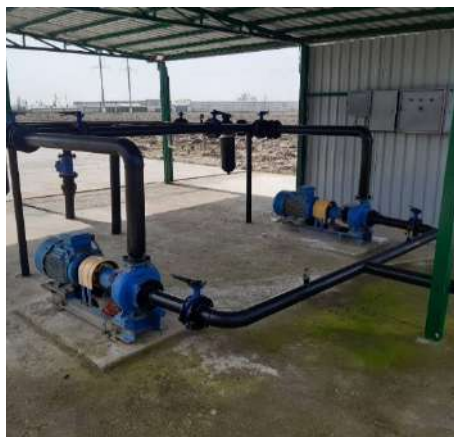
5-расм. Ғўзани томчилатиб суғориш тизими насос станциялари кўриниши
