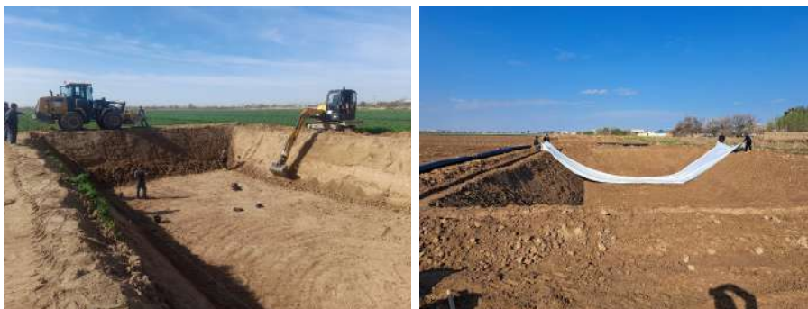
3-расм. Ҳовуз-тиндиргичларни тайёрлаш жараёни
