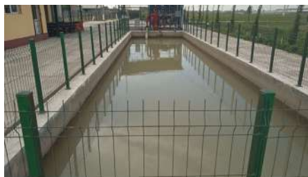
4-расм. Бетон қопламали ҳовуз-тиндиргич
