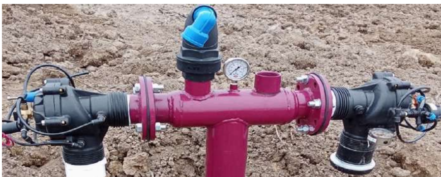
14-расм. Стационар ёмғирлатиб суғориш тизими гидрантлар
