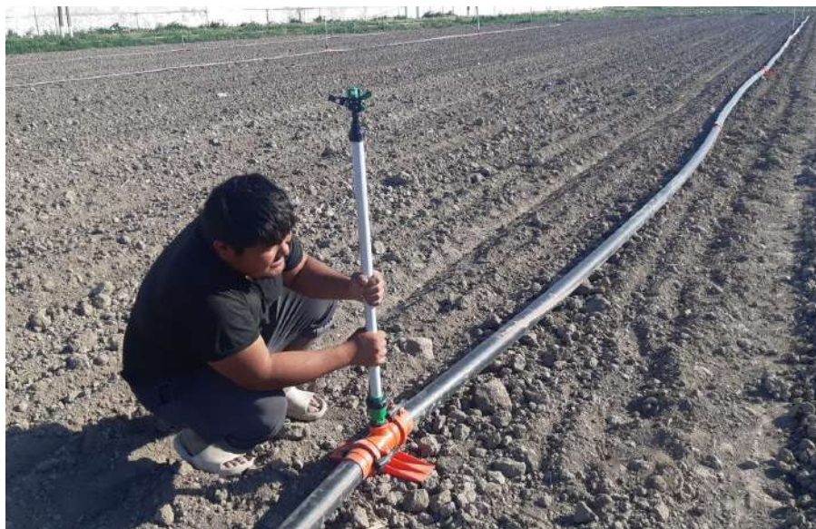
31-расм. Спринклерларни ўрнатиш жойлаштириш
