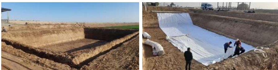
2-расм. Ҳовуз-тиндиргични тайёрлаш жараёни
