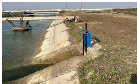
2.3-расм. Ясси сув дарвозали сув олиш иншооти
