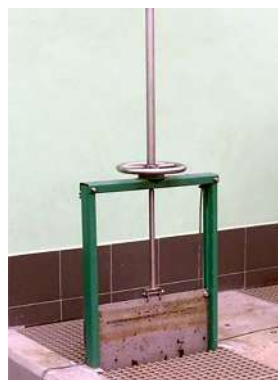
2.4-расм. Механик кўтаргичли сув дарвозаси
