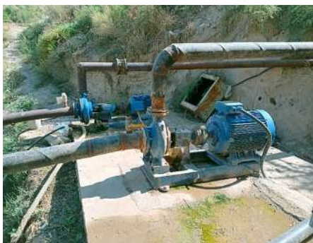
1.6-расм. Суғориш тармоғидан насос ёрдамида сув ҳисобини юритмасдан сув олиш
