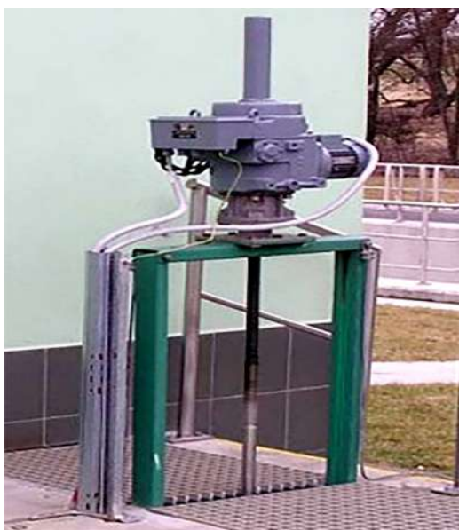
2.6-расм. Электрлаштирилган сув дарвозаси
