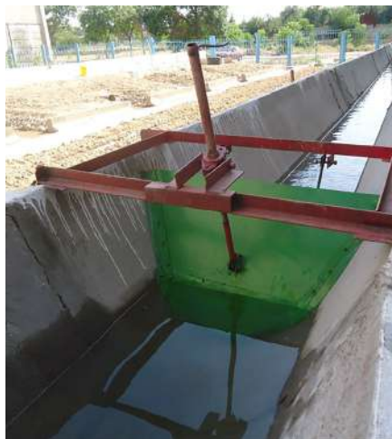
2.8-расм. Параболик щитли сув дарвозаси
