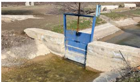
2.2-расм. Ясси сув дарвозали сув тўсиш иншооти
