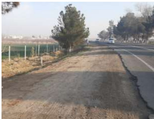
Существующие подземные кабели в Джаркурганском и Термезском районах (1599–1619 км)
