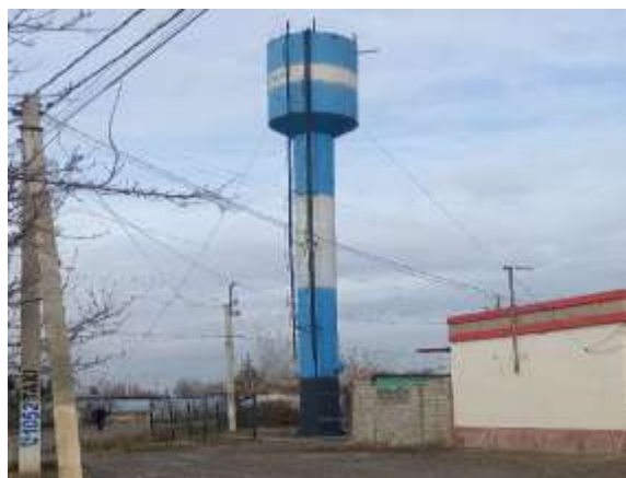
Водонапорная башня в Термезском районе
