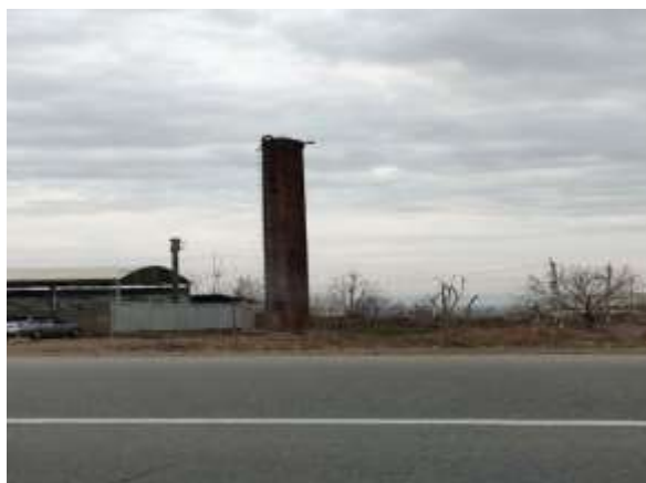
Водонапорная башня в Кумкурганском районе
