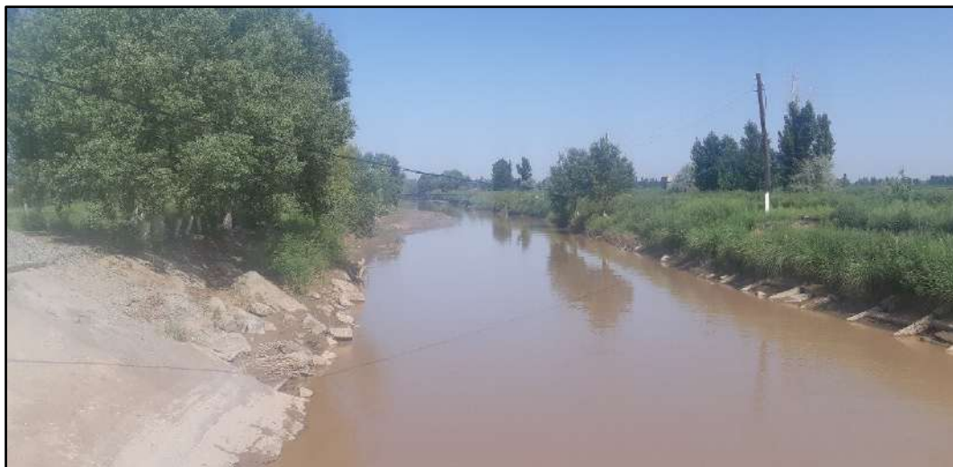
Рисунок 8. Размыв откосов канала и наносы в земляном канале в Хорезмской области
