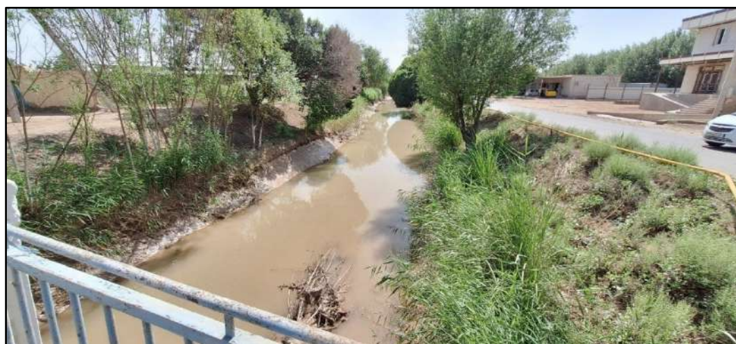
Рисунок 21. Канал Остана, подлежащий реконструкции и облицовке в фазе II
