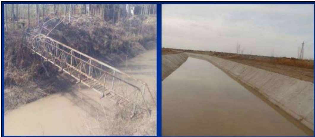
Рисунок 16. Канал Р-9 до и после облицовки в фазе I
