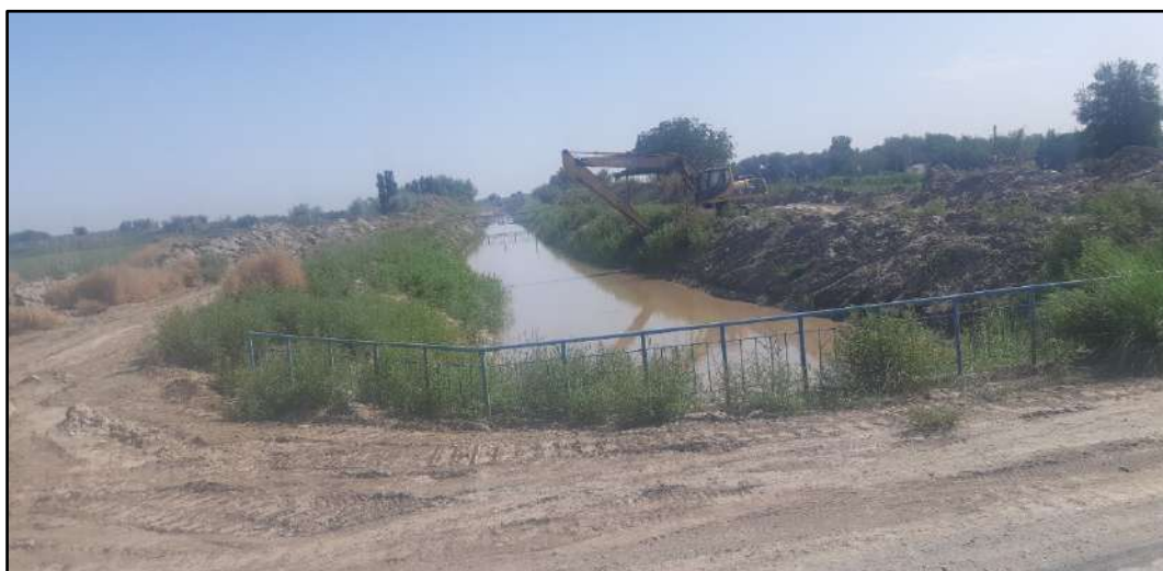
Рисунок 12. Эксплуатационное обслуживание земляного канала и стабилизация поперечного сечения в Хорезмской области
