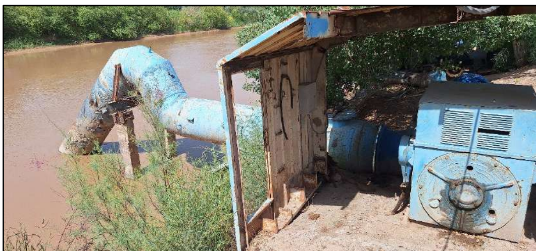
Рисунок 14. Изношенная насосная станция на магистральном канале Ташсака
