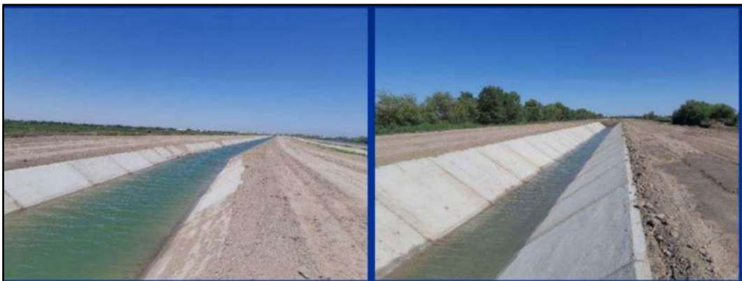
Рисунок 17. Новый канал Шават (ПК 68+00 – ПК 74+00), реконструированный в фазе I
