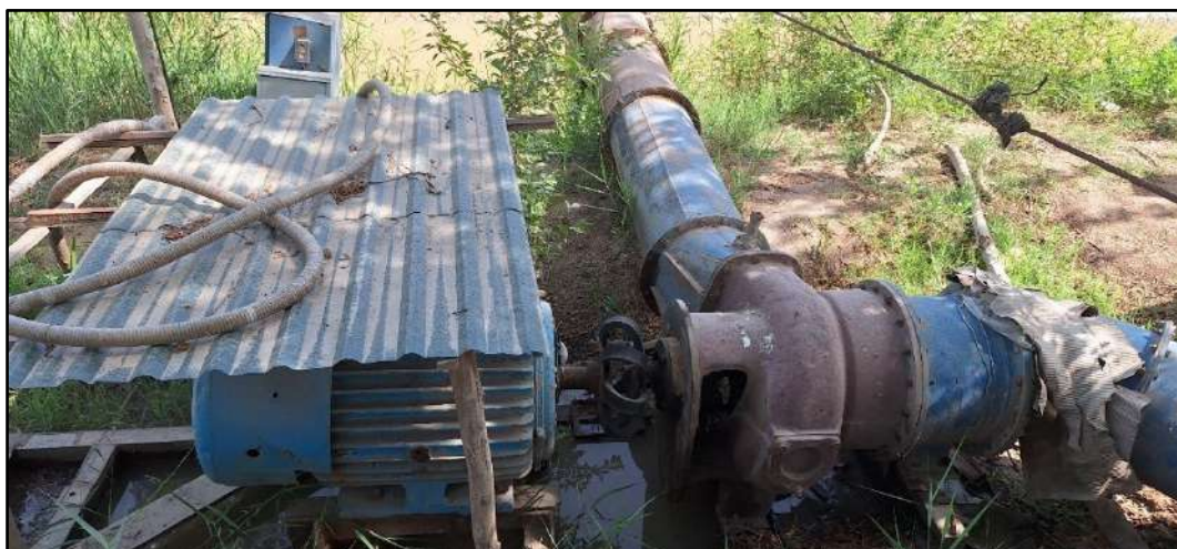
Рисунок 15. Устаревшая насосная станция на магистральном канале Ташсака без какой-либо стандартной установки и здания насосной станции.
