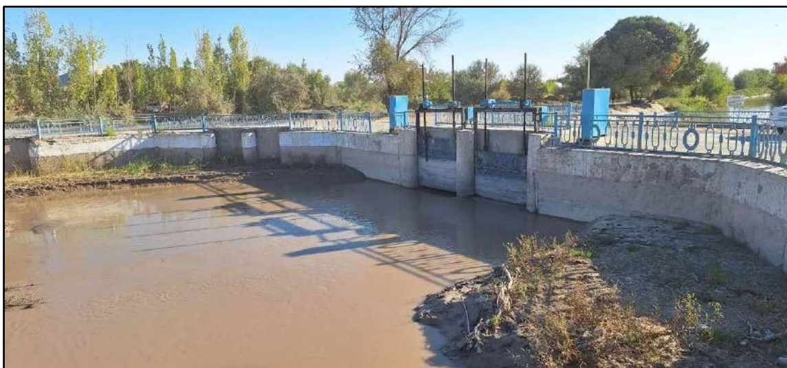
Рисунок 31. Водовыпускные сооружения на оросительном канале Полван-Газават
