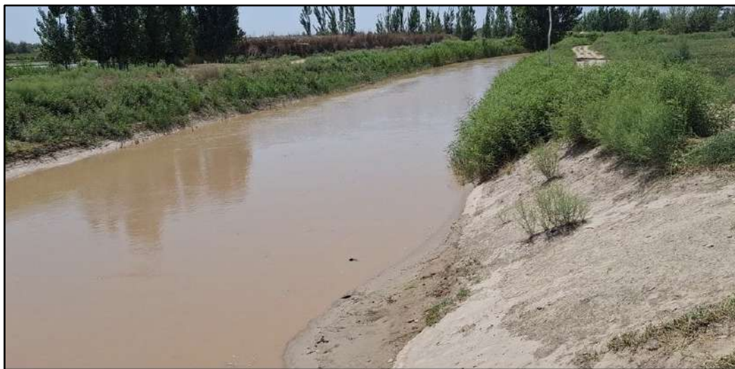
Рисунок 20. Канал Хонабад, подлежащий реконструкции и облицовке в фазе II
