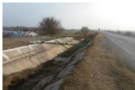
Рис. 5.1.10. Внутрихозяйственный земляной канал
