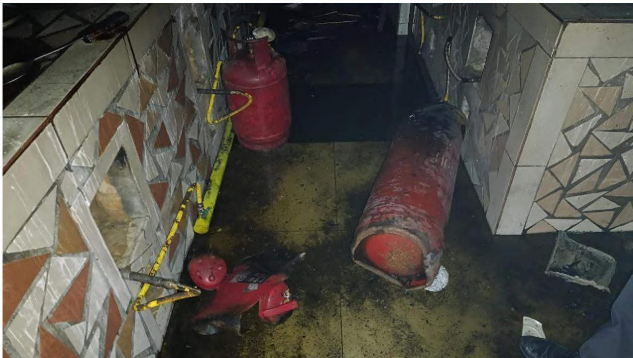
Holat sodir bo'lgan oshxonada mavjud bo'lgan 2 dona suyultirilgan gaz ballonlarining yorilgan holatining ko'rinishi.
