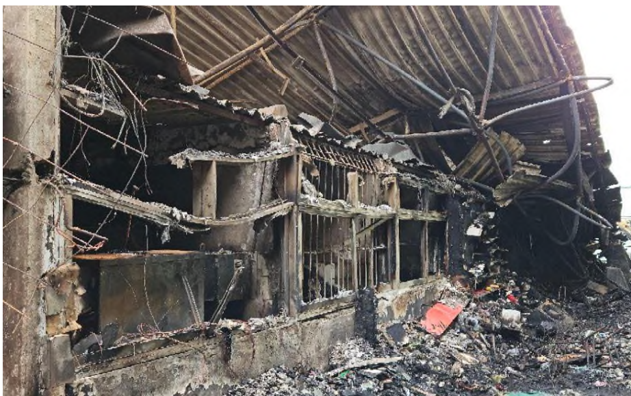
Bozordagi do'kon orqali tortilgan elektr simlarida yuzaga kelgan avariya (qisqa tutashuv)ning ko'rinishi
