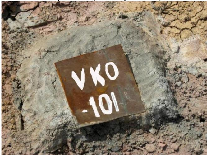
Рис. 3 Пример консервации буровой скважины
